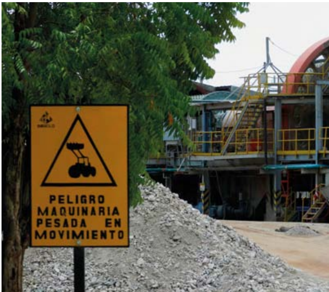
Goldverarbeitungsanlage Mine El Limón/Nicaragua; Quelle: Steff Wassermann
