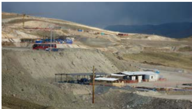
Verarbeitungsanlage von Xstrata bei der Mine Tintaya. Foto: Vikariat von Sicuani
